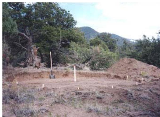
Usando la misma estaca se marca el círculo interior y el exterior del muro. Además se debe marcar la entrada, o entradas a la vivienda para disponer una mayor sección en la cimentación puesto que tiene que soportar la carga del hueco de entrada.
