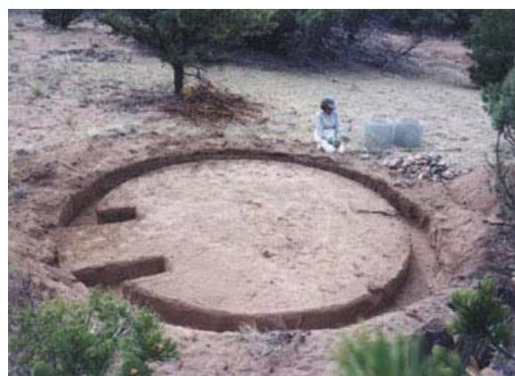
Clasificando la cimentación según los materiales que empleemos podemos encontrar diferentes tipos. Las más común es a base de gravas que se depositan sobre el hueco excavado. En la zonas donde el terreno no drene bien es aconsejable poner antes del material de cimentación una malla de alambre para que el terreno no se mezcle con la cimentación. Estas gravas pueden mezclarse a su vez con arena para que no queden huecos libres. Las gravas pueden ser de diferentes tamaños.
