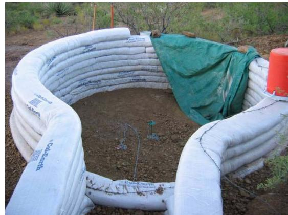
En segundo lugar, se pueden utilizar los sacos de arena con función estructural pero con diferentes materiales en cubierta, pudiendo crear de este modo la forma de la planta que uno quiera. Lo más usual sería utilizando cubierta de madera.
