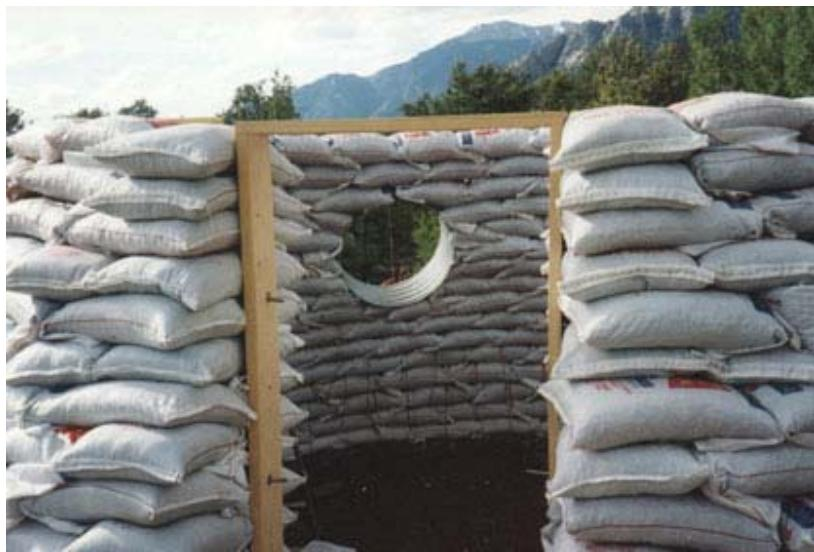
En el caso que se observa en la fotografía se colocará un encofrado con forma de arco, que librará de peso al hueco.
