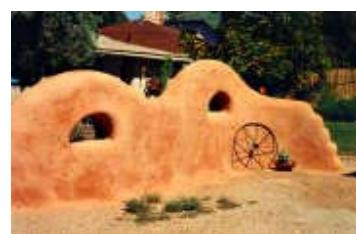
En cuanto al impermeabilizante de los muros se suele poner desde la cimentación hasta la segunda o tercera fila sobre el terreno, aunque el propio material del que están hechos los sacos (polipropileno) impermeabiliza, pero para mayor seguridad, se añade algún tipo de impermeabilizante.
