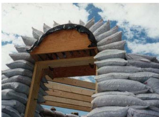
Como podemos apreciar en esta primera imagen, se colocan pequeñas piezas de madera que a posteriori anclaran el cerco del hueco. Aquí aparecen mediante tuerca y perno pero aceptaría soluciones de anclado por maderas, evitando el empleo de metales.
