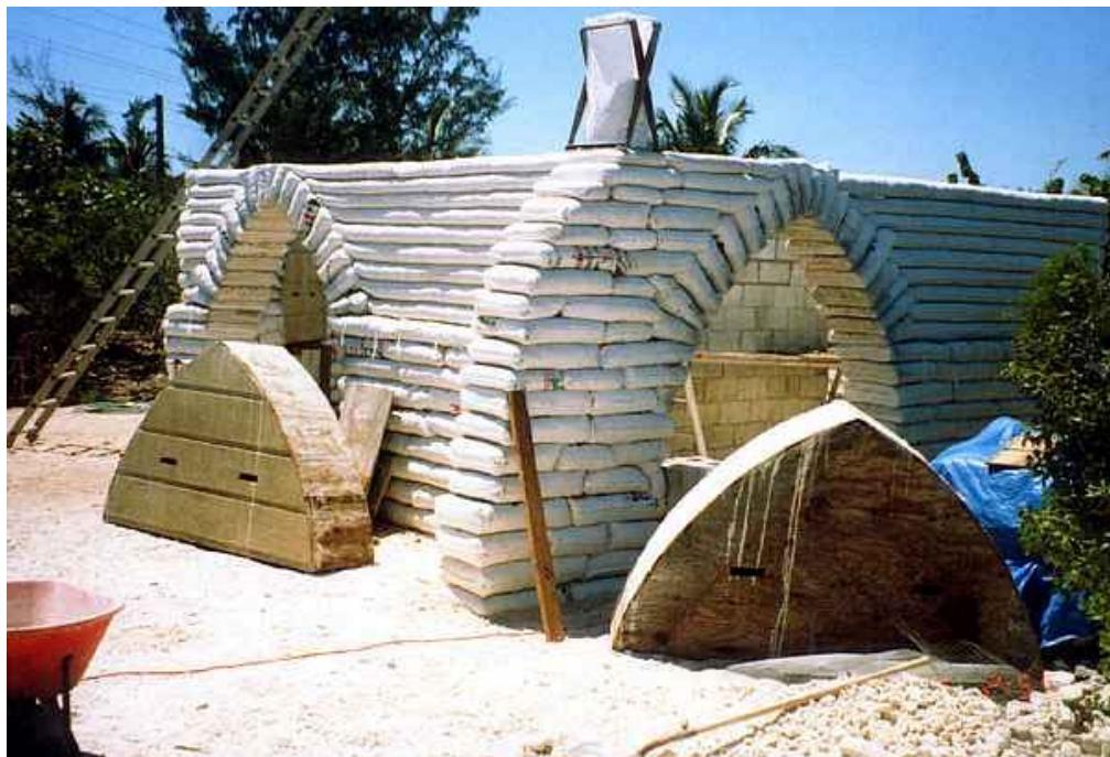
Las ventanas se pueden solucionar también con arcos, sino la disposición de un dintel de madera es la solución más efectiva.
