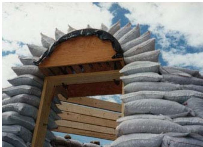
Este sistema, si se efectúa con las arenas y sacos adecuados y si se prensa adecuadamente, adquiere estabilidad de una manera sorprendente. Como es el caso de la siguiente imagen, en la que se uso arena de playa, que, con su humedad relativa resultaba plástica y estable.
