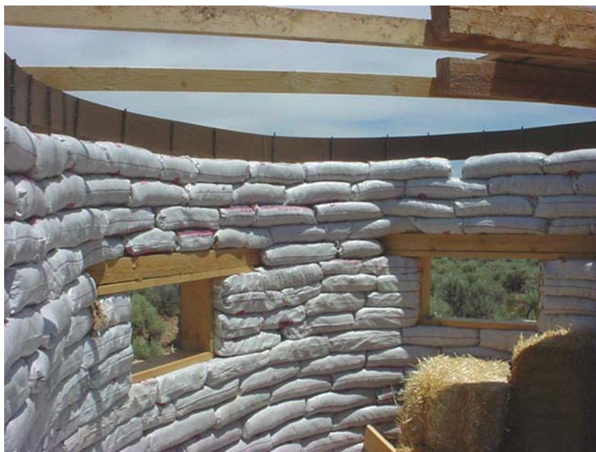
Estas soluciones mostradas son de fácil ejecución, sin ningún tipo de adherentes, solo juntas secas y modulares, algo muy efectivo para poder tutelar a cualquiera en su ejecución.
