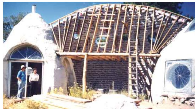
En el caso de utilizar los sacos de arena como cerramiento y no como elemento constructivo, existen diferentes tipos de elementos estructurales que podrían ser incorporados, estructura de pilares de madera o de hormigón, o mezclando ambos. De esta manera la función de los sacos de arena sería simplemente la de proporcionar masa térmica y cerrar el conjunto. La cubierta en estos casos no suele ser de sacos de arena sino más bien suele tratarse de otras tipologías de cubierta.
