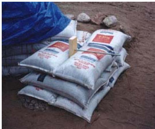
A medida que avanzamos verticalmente con las hiladas de sacos de arena, vamos introduciendo estos anclajes, siendo lo más efectivo disponerlos cada 50 cm. Una vez se llegue a la altura total del hueco se coloca el cerco.
